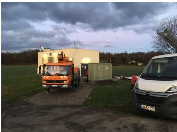
Bild 10: Am 18. Januar 2018 wurde das Dach der Gasübernahmestation Biskirchen durch den Orkan Friederike abgedeckt. Noch während des Sturms und unter Beteiligung aller technischen Abteilungen wurde in der Nacht ein provisorisches Dach geschaffen, um das Gebäude und die wichtige Technik zu schützen. Der Betrieb der Reglerstation konnte durch das sofortige Handeln unterbrechungsfrei weitergeführt werden. Im Laufe des Jahres wurde ein neues Dach und eine neue Blitzschutzanlage errichtet.
