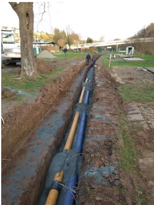
Bild 5: Die zwischen den Stadtteilen Odersbach und Kirschhofen an einer Brücke über die Bundeswasserstraße Lahn im FFH-Natura 2000 Gebiet verlaufenden Hauptleitungen für Gas, Wasser und Strom 20kV sind nach 35 Jahren Nutzungsdauer stark sanierungsbedürftig und werden künftig in einem Düker durch die Lahn geführt. Das Bild zeigt die in 2018 abgeschlossenen Vorarbeiten zur Umverlegung; das Dükerbauwerk wird Anfang 2019 errichtet.
