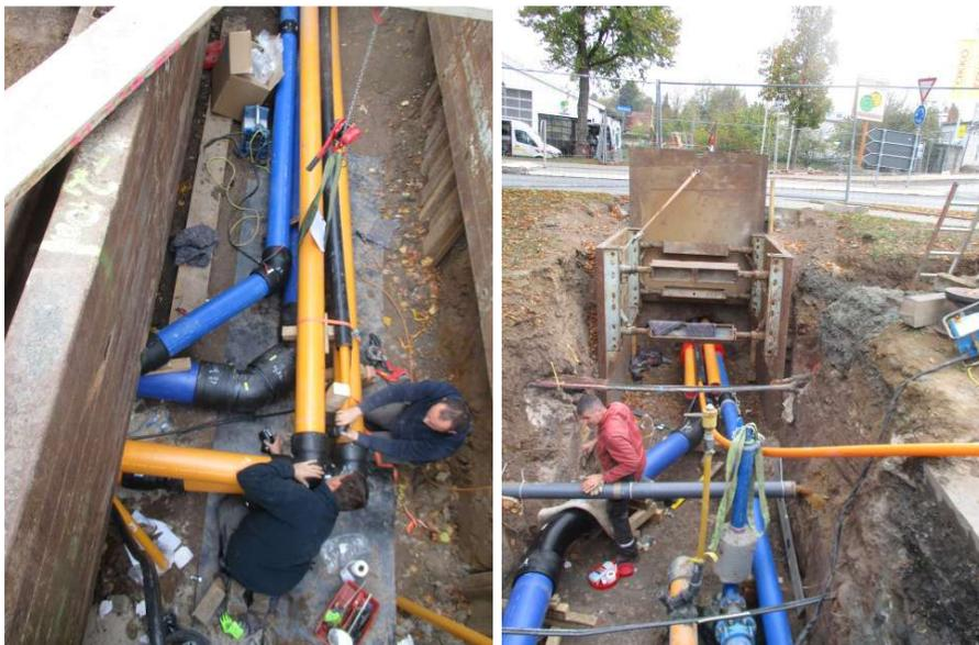
Bild 12: Eine der maßgeblichen Bau- und Investitionsmaßnahmen in 2018 war die Erneuerung von Versorgungsleitungen entlang der B456/Frankfurter Straße (Bild: Querung Höhe Käsmarkstraße).
