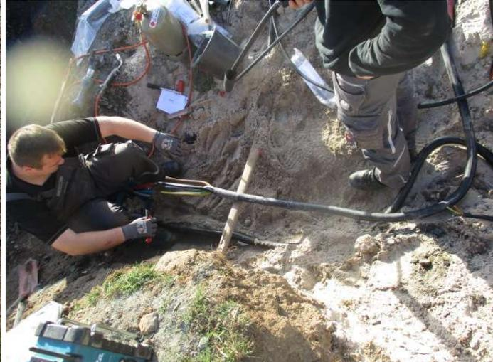
Bild 4: In Steillagen in Ahausen, in der Straße „Im Bangert“ und am Windhof wurden Mittelspannungskabel des 20kV-Stadtrings -teils unter besonderen topografischen Bedingungen- erneuert. Bei den in der Vergangenheit sehr zuverlässigen masse- und ölisierten Kabeln kam es während der letzten 3 Jahre zu Ausfällen. Die Kabel wurden entsprechend der Schäden und anhand von Messungen klassifiziert; allein in 2018 wurden 3,3 km ausgetauscht.
