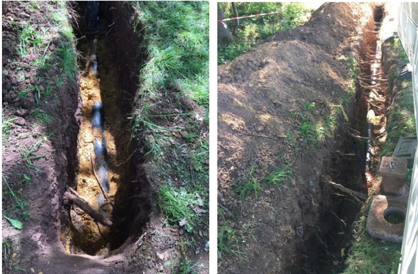
Bild 11: Wurzeingriff mit Quetschung und Schädigung der Isolation der Gashochdruckleitung im Innenstadtbereich Weilburg: Nachdem wir bei einer turnusmäßigen Überprüfung die Eingriffe an die innerörtlichen Transportleitung im Bereich Braunfelder Weg - Königsberger Straße festgestellt hatten, wurde die unmittelbare Gefährdung durch Fällung von 20 Bäumen beseitigt.
